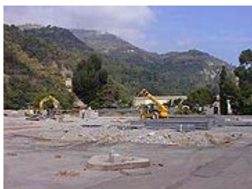
Construcción de la fábrica piloto, situada en Niza (Francia)
